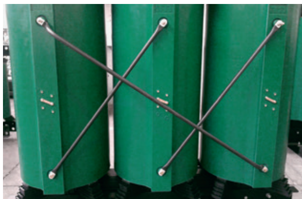
Пример выполнения выводов обмотки высокого напряжения
