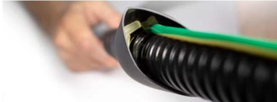
7. В образовавшуюся воронку всыпать термоплавкий клей и равномерно распределить его в манжете.
