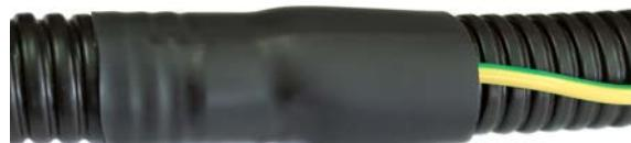
6. Усадить часть манжеты, заходящую на нижнюю часть изоляции, техническим феном (не допускается использование горелок).
